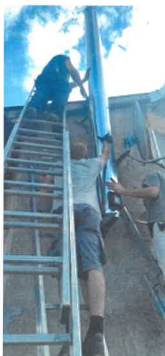
Duplafalú saválló szigetelt kémények beépítésének kivitelezése
