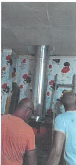
Duplafalú saválló szigetelt kémények beépítésének kivitelezése
